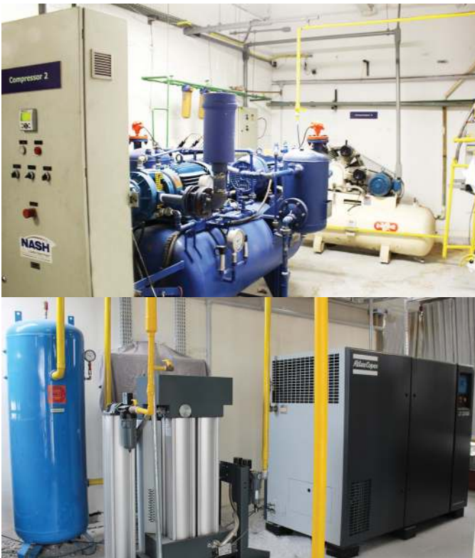
Figura 6 - Troca do sistema de Ar Comprimido. Fotos: Jonatas Oliveira
