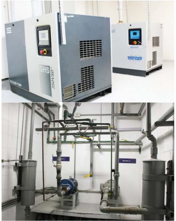
Figura 7 - Troca do sistema de Vácuo. Fotos: Jonatas Oliveira
