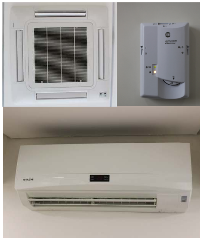
Figura 4 - Equipamentos Hidrônicos. Fotos: Jonatas Oliveira
