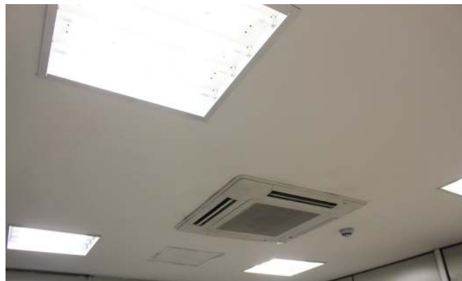
Figura 2 - Substituição do parque de iluminação para LED. Foto: Jonatas Oliveira
