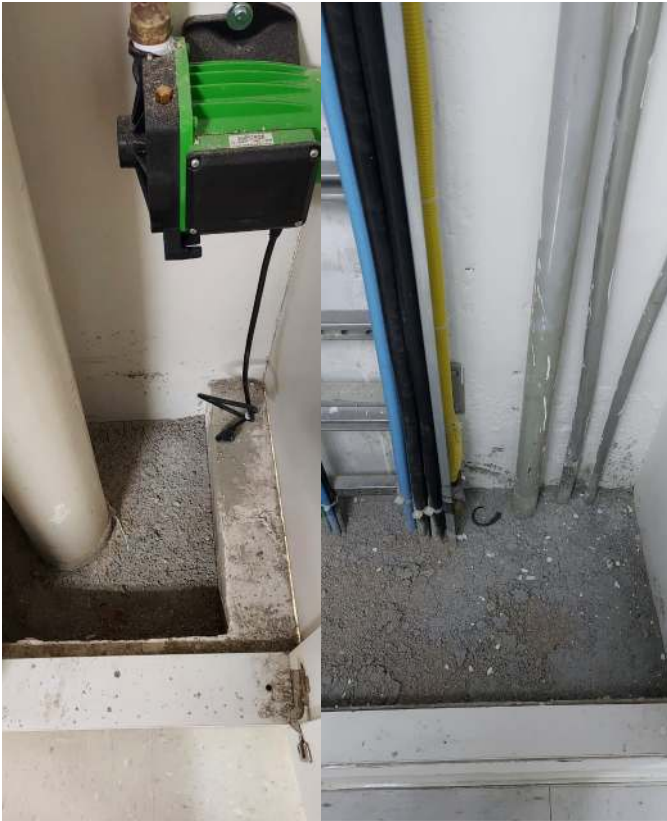
Figura 3: Selagem corta-fogo. Foto: Arquivo Pessoal
